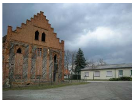
Leaderprojekt „ehemalige Brennerei des Gutshauses Karow“
