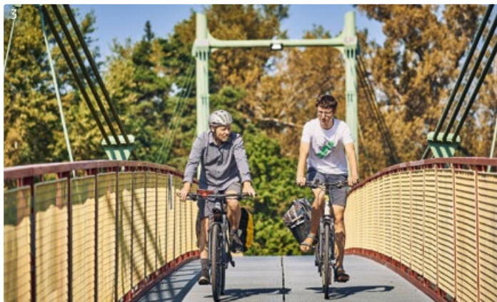
▲ Fahrradbrücke am Zusammenfluss der Iser mit der Elbe
